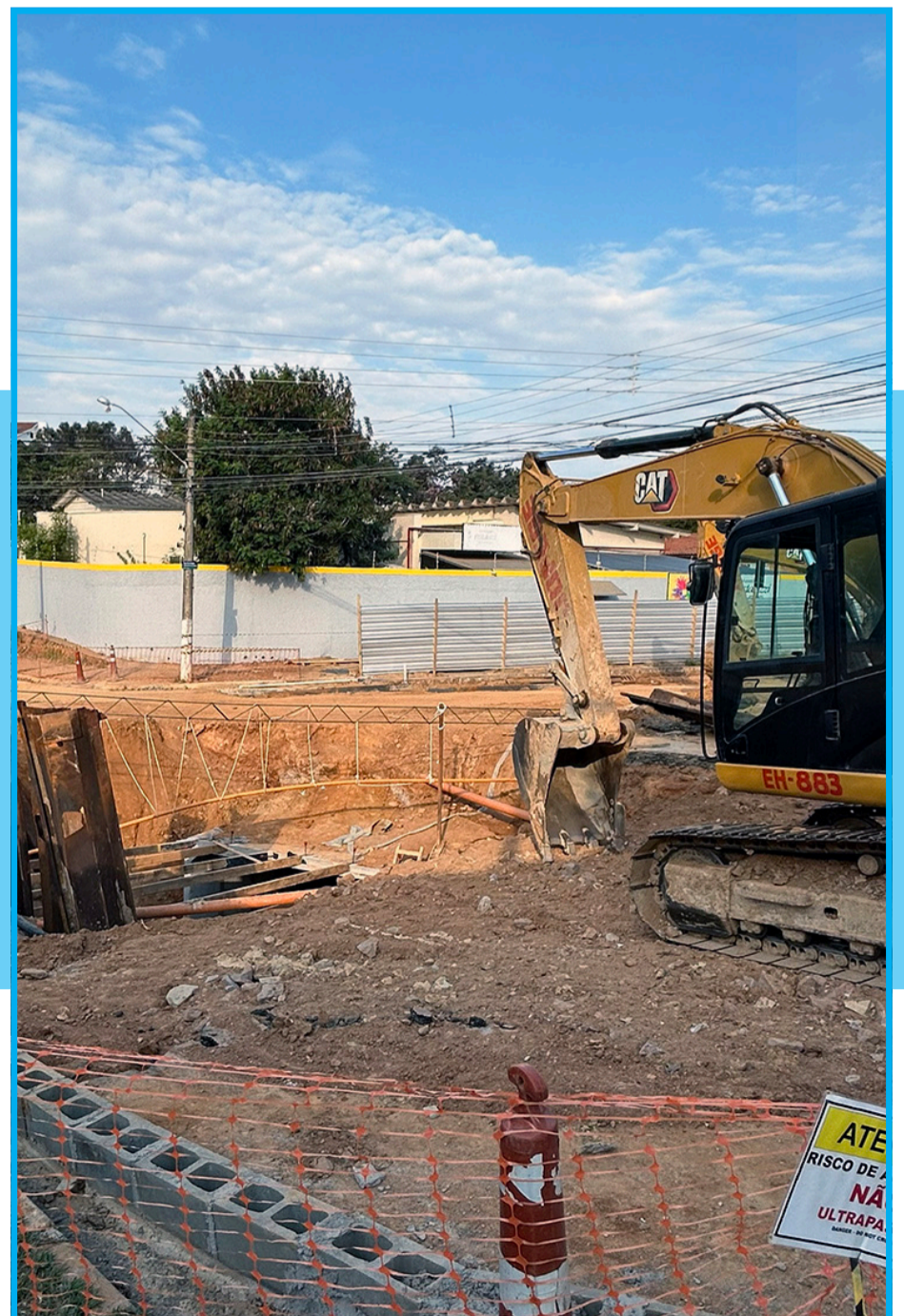
Obra RP-1 na Praça Paranapanema (Foto: Sophia Roselli)
