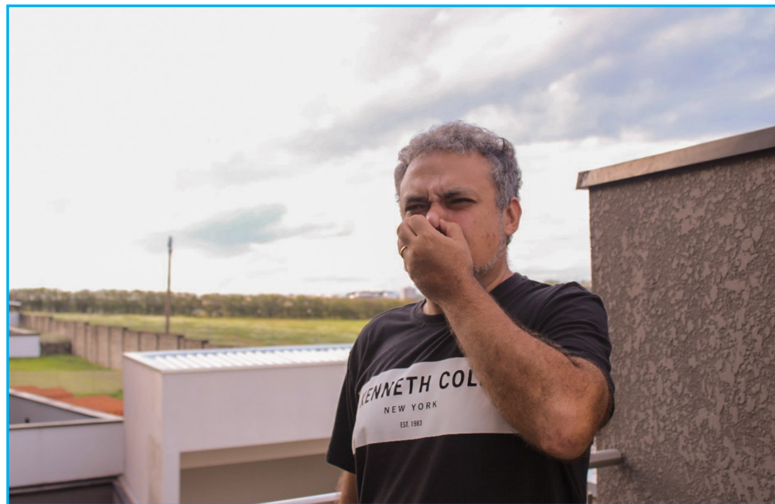
Luiz Antônio Gomes Filho reclama do mau cheiro da Estação de Tratamento de Esgoto, na varanda de casa (fotos: Clarice Cardoso)
