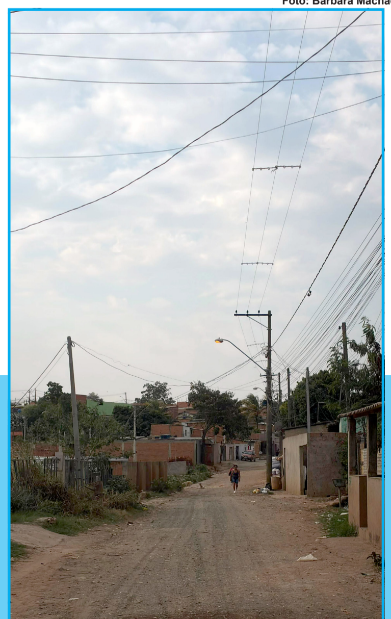
Rua principal sem pavimentação (Foto: Bárbara Machado)
